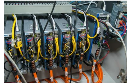
Die Einspeiseeinheit AKD-C (rechts) übernimmt die Versorgung der dezentralen Servoregler. ME 2 setzt ferner Schaltschrankumrichter der Reihe AKD an, um weitere Antriebe außerhalb des Drehtisches zu regeln.
